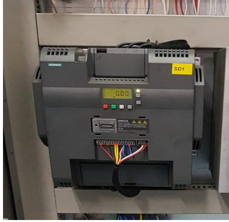
Şekil 4.2. Hız kontrol ünitesi
