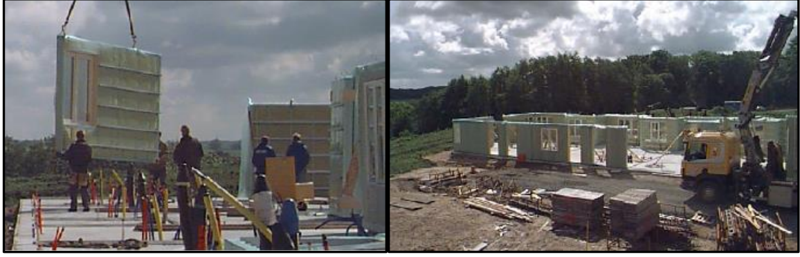
Şekil 11. Panel sistem bina inşaatı (Dubina, Ungureanu & Landolfo, 2012)
