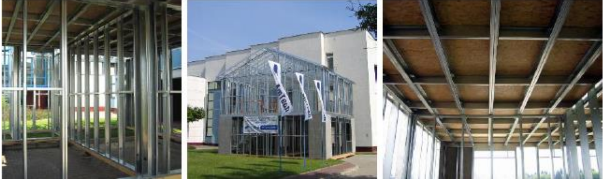
Şekil 9. Çerçeve sistem konut inşaatı (Dubina, Ungureanu & Landolfo, 2012)
